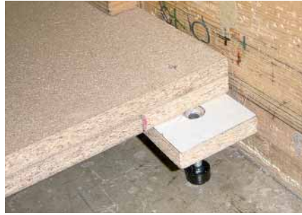
壁際端部納まり 補強脚NS-NP型
