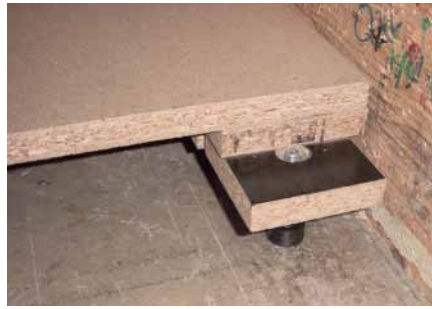
壁際部納まり 新型支持脚 NS-III型
