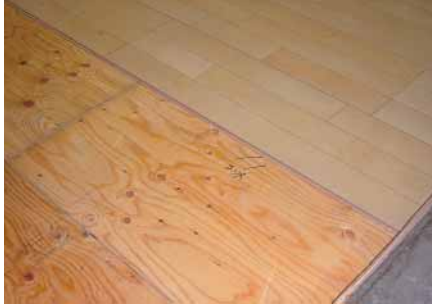
下地合板・フローリング施工状況
